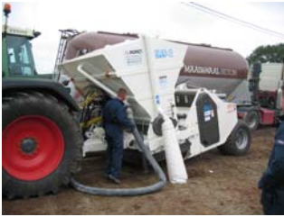
Befüllung mittels Druckluft vom Silofahrzeug/ Filling of binding agent container from tanker
